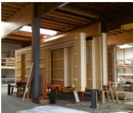
Hoher Vorfertigungsstandard bei Holzbaumodulen
