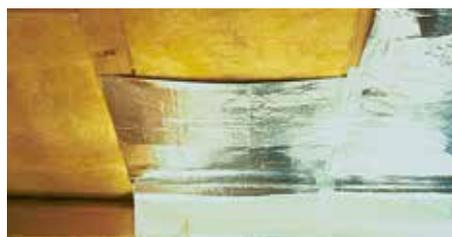
Abb. 3: Kapillar nicht wasseraufnahmefähige Schichten sind z. B. Mineralwolle oder Aluminiumfolie. Fraglich bleibt jedoch, wo das Kondensat (bis 500 g/m<sup>2</sup>) zwischengespeichert wird. Bild: Ampack
