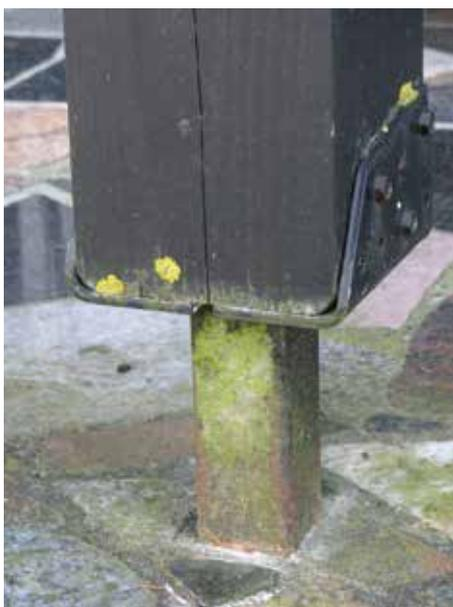
Abb. 9: Der Pfostenträger ragt bei diesem Beispiel sogar über die Kante der Holzstütze hinaus. Niederschlagswasser kann so in großer Menge in die Hirnholzfläche eindringen.
