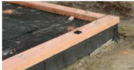
Abb. 2: Bei erdberührten Bauteilen ist mit einem andauernden Feuchteeintrag aus dem Erdreich zu rechnen. Unter der Holzschwelle ist daher eine Schutzschicht (z. B. Bitumen-Schweißbahn) einzubauen.
