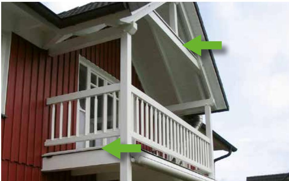
Abb. 8: Die horizontalen Holzträger sind bei diesem Balkon durch eine Metallabdeckung bzw. durch eine Abdichtung mit Abdeckbrettern geschützt.
