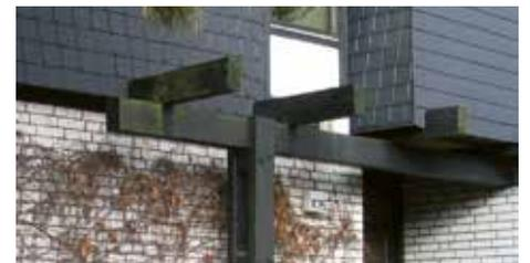
Abb. 5: Diese Holzträger sind weder durch einen Dachüberstand noch durch eine Abdeckung vor der Witterung geschützt. Hier liegt die Gebrauchsklasse GK 3.2 vor. Die Holzfeuchte kann über 30 % betragen. Somit wäre ein Befall mit Holz zerstörenden Pilzen möglich. Es ist eine Holzart mit hoher Dauerhaftigkeit zu verwenden. Geeignet ist das Kernholz der Eiche. Nadelholzarten sind hier nicht zulässig.
