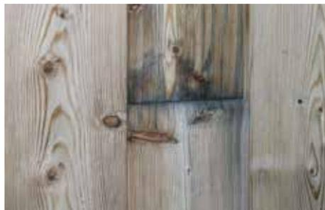
Abb. 7: Stumpfe Stöße sind bei senkrechten Brettbekleidungen (z. B. Holzfassade) nicht zulässig. Diese können Kapillarfenen bilden und zur verstärkten Aufnahme von Wasser über das Hirnholz führen.
