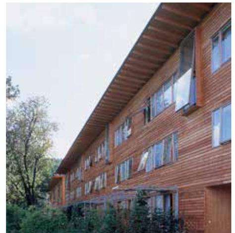
Abb. 7: Bei diesem dreigeschossigen Wohnbau in Trofaiach (Steiermark) sind die Voraussetzungen für ein belüftetes Flachdach günstig: freie Lage mit Windanströmung und große Belüftungsquerschnitte. Bild: proHolz Austria
