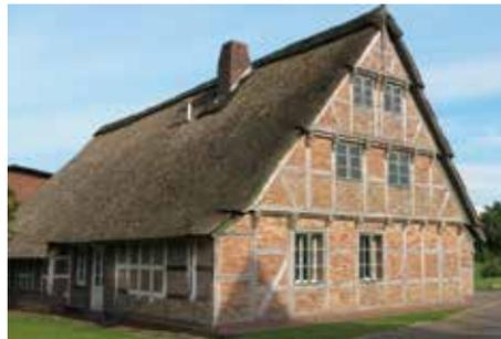
Abb. 1: Große Dachüberstände schützen das Holzfachwerk an den Traufseiten. Der hohe Westgiebel allerdings ist den Niederschlägen besonders ausgesetzt. Die Wandhöhe führt zu durchsackender Feuchtigkeit und damit zu erhöhter Feuchte im Sockelbereich.
