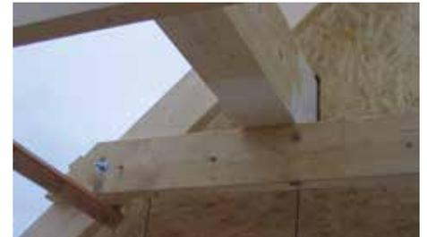
Abb. 5: Aufgrund der Formstabilität wird für Mittelpfetten der Einsatz von Brettschichtholz oder Balkenschichtholz empfohlen. Achtung: Bei auskragenden Pfetten kann Brettschichtholz der NKL 3 notwendig sein.
