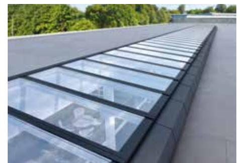
Abb. 4: Sind für das Flachdach mehrere bzw. größere Einbauten vorgesehen, so sollte eine unbelüftete Konstruktion ausgeführt werden. Bild: Velux Deutschland GmbH
