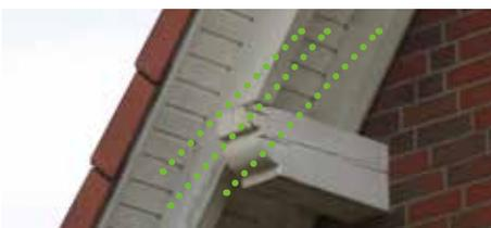
Abb. 2: Bei großen Dachneigungen sind die auskragenden Pfetten Wind und Wetter stark ausgesetzt. Die Pfettenköpfe sind hier profiliert, die gefährdete Hirnholzfläche wird zumindest verringert.
