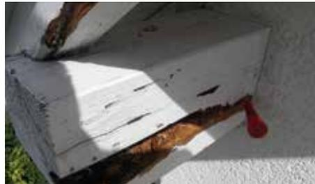
Abb. 3: Schäden an einer Mittelpfette. Der Pfettenkopf steht gegenüber dem Sparren etwas vor, das Hirnholz ist ungeschützt. Foto: Robert Ott, Gammertingen
