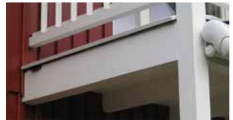
Abb. 2: Konstruktiver Holzschutz bei Balkonen: Hirnholz abgedeckt, oberseitige Abdeckung, Luftfugen statt Wasserfugen, kein Stauwasser. Mögliche Holzarten sind sodann z. B. Douglasie oder Lärche (Kernholz).
