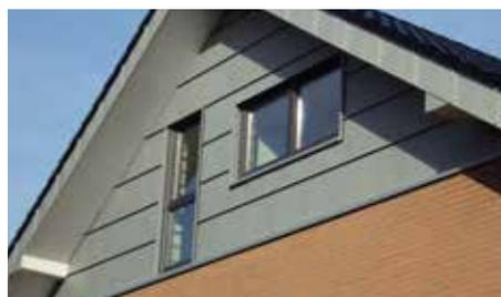
Abb. 4: Die Mittelpfetten sind hier eingehaust: Stirnseitige Bekleidung mit Titanzink und seitliche Bekleidung aus wetterfestem Material. Foto: Buxel GmbH, Bauklempnerei, Rheda-Wiedenbrück
