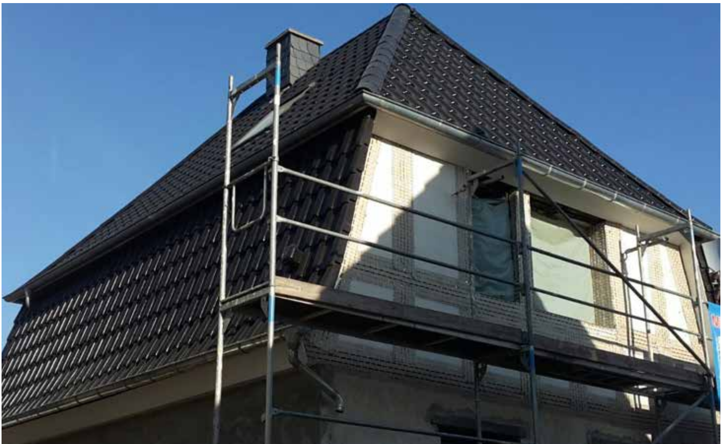
Noch steht das Gerüst, doch die Sanierung des neuen Dachs samt Dämmung und neuen Fenstern ist abgeschlossen.
