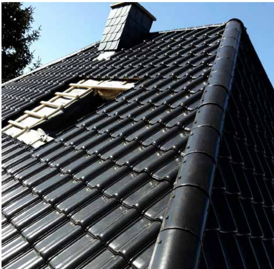
Die Standardziegel und die Firstziegel sind verlegt, das neue Dachfenster muss noch eingebaut werden.
