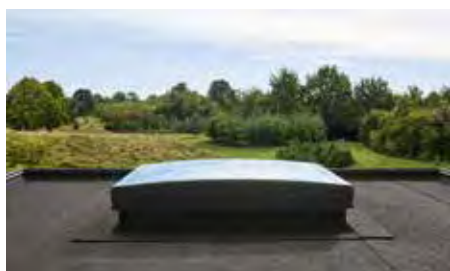
Die Flachdachfenster in der Ausführung Konvex-Glas und Kuppel lassen sich mit einer Solar-Hitzeschutzmarkise ausstatten.
