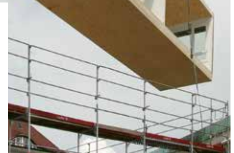
Modulbauweise, Foto rosengruen.de
