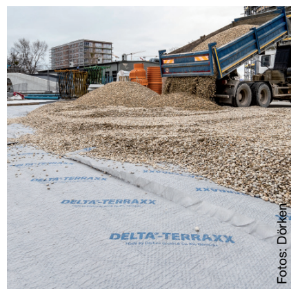
Die universelle Schutz- und Dränbahn lässt sich vielseitig einsetzen, auch auf Flachdächern mit schwerem Oberflächenschutz aus Kies oder unter extensiv und intensiv begrünten Flächen.
