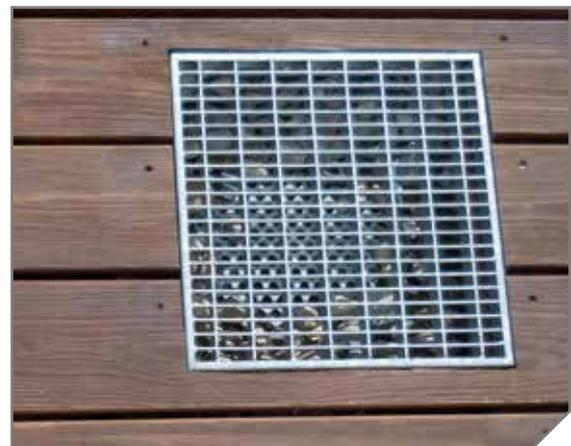
Für Wartungsarbeiten muss die Entwässerung immer zugänglich sein. Mit Entwässerungsrosten ist das einfach möglich.
