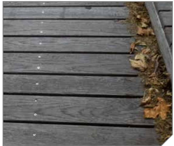
*Laub und Schmutz muss aus den Fugen entfernt werden, damit keine Pilze entstehen können.*
