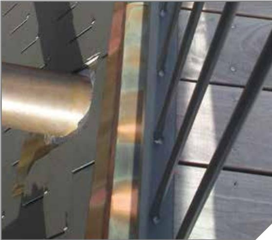
Oberflächenwasser führt in Verbindung mit den Holzinhaltstoffen zur Verfärbung des Kupferblechs.
