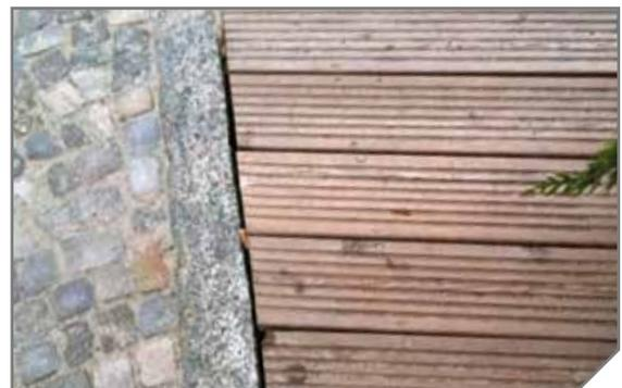
Bei Terrassen, die ebenerdig erstellt werden, sollten dauerhafte Holzarten eingesetzt werden.
