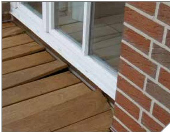
verarbeitet werden. Beim Hobeln von drehwüchsigem Holz kann es zu Faserausrisen und rauen Oberflächen kommen. Drehwüchsiges Holz kann eine sehr interessante Optik haben und wird deswegen von einigen Kunden bevorzugt.
