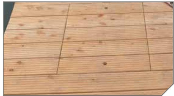
Bei Revisionsklappen aus Holz muss der bauliche Holzschutz beachtet werden.
