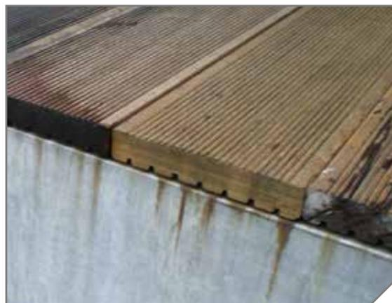
*Auswaschungen aus Bangkirai, die sich nur durch eine konstruktive Lösung verhindern lassen.*
