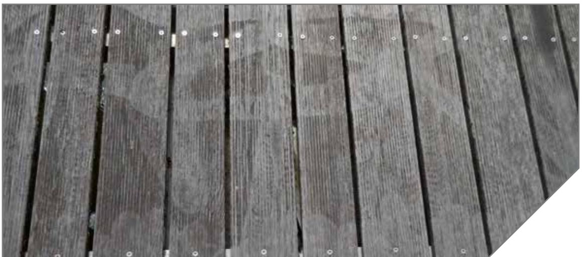
*Die Fläche wurde mit einem Hochdruckreiniger gereinigt, wodurch sichtbare Farbunterschiede auf der Oberfläche entstanden sind.*
