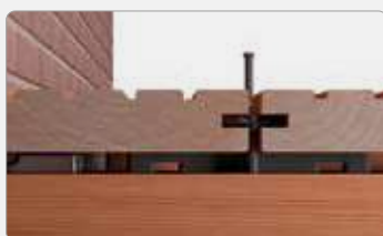
Beginnen Sie mit dem Terrassenwinkel oder StarterClip.
