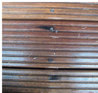
Reaktion der Holzinhaltstoffe mit Schrauben
