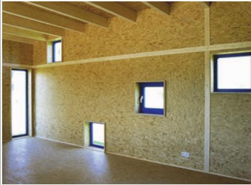
**Techn. Grundlage**®: DIN EN 13 986 mit DIN EN 300 (CE-Kennzeichnung) bzw. die allgemeine bauaufsichtliche Zulassung® (Z); (Ü-Kennzeichnung).
