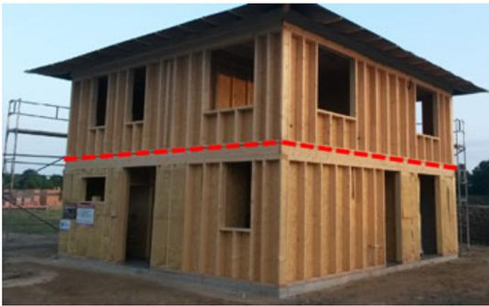
**Abb. 85:** Die Lasten sollen dorthin geleitet werden wo die steifen Wände als Auflager der Deckenscheibe zur Verfügung stehen. Die Deckenscheibe muss kraftschlüssig an die Wandelemente angeschlossen werden.
