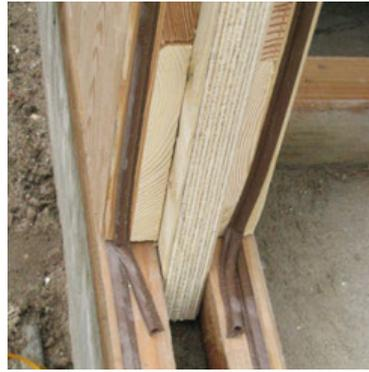
**Tabelle 105:** Elementverbindung mit Stoßbrettern aus Holzwerkstoffplatten (OSB oder Sperrholz). Bilder: Meyer Ingenieurbüro
