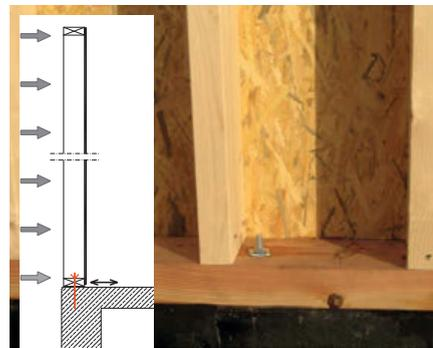
Vertikale Verankerung: Das Verankerungselement (Zuganker) sichert die Wand gegen Abheben. An der vertikalen Rippe wird mit einer hohen Anzahl von Verankerungsstiften (Sondernägeln) eine hohe Last in den Stahlwinkel eingeleitet (Foto in Abb. 36). Der Dübel reicht durch die Schwelle in den Betonunterbau und liegt nahe der langen Metalllasche, um eine Verformung des Stahlbauteils möglichst gering zu halten
