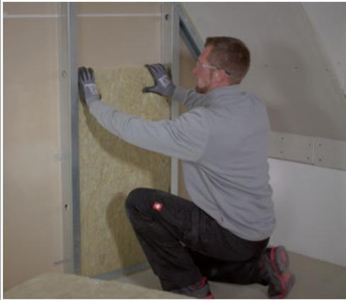
**Techn. Grundlage:** DIN EN 13 162 bei Mineralwolle, DIN EN 13 171 bei Holzfaser (CE-Kennzeichnung erforderlich).
