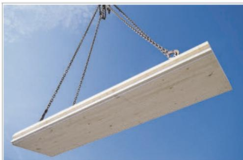
**Technische Grundlage:** Produktion nach EN 14080, Festigkeitsortierung nach EN 14081.
