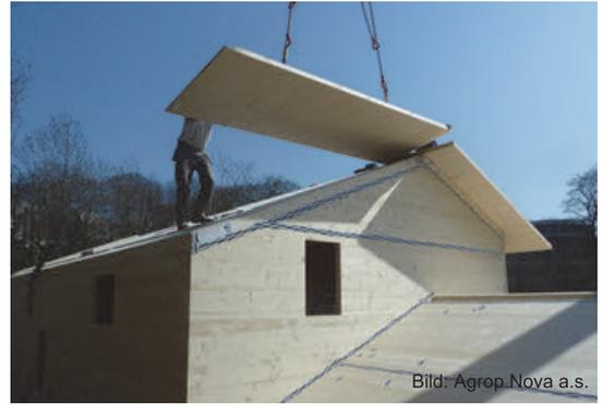
Holzmassivdecken bieten eine attraktive Untersicht. Durch einen Fußbodenaufbau mit Schüttung als Rohdeckenbeschwerung lässt sich ein sehr guter Trittschallschutz auch im tieffrequenten Bereich erzielen (siehe B • 8 • g »Schallschutz«).
