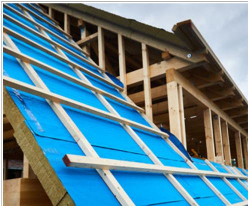
**Techn. Grundlage:** DIN EN 13 171 bei Holzfaser, DIN EN 13 162 bei Mineralwolle (CE-Kennzeichnung erforderlich).
