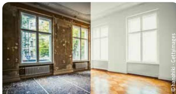
Hinzu kommt, dass durch Undichtigkeiten und nicht isolierende Verglasung im Sommer Hitze und im Winter Kälte sowie feuchte Zugluft in die Innenräume dringen. Die gesteigerte Luftfeuchtigkeit setzt sich zunächst als Kondenswasser am Fenster ab, sucht sich aber im schlechtesten Fall die kälteste Stelle am Mauerwerk und kann dort gesundheitsschädlichen Schimmel bilden und auf Dauer die Bausubstanz schädigen.
