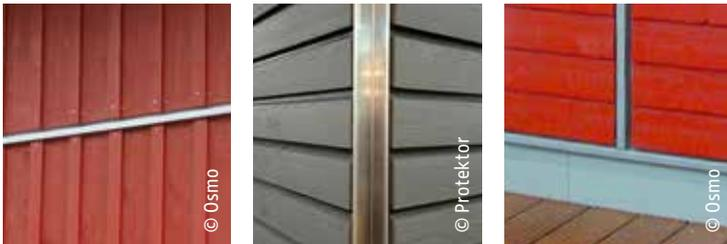
Aluminium-Profile schützen Holzfassaden zusätzlich an sensiblen Schnittstellen vor Staunässe und setzen optische Akzente: Übergangprofile verhindern ein Durchnässen der Holz-Stirnseiten, Eckprofile schützen sensible Kanten und schaffen sichere Übergänge, Bodenprofile schützen vor Spritzwasser.
