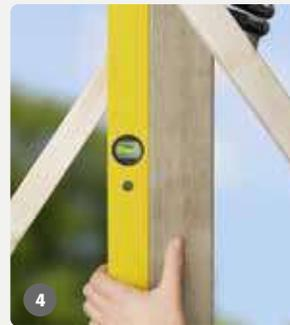
Mit einer Wasserwaage kontrollierst Du, ob die Pfosten im Lot stehen. Korrekturen sind solange möglich, bis der Beton abbindet. Achte daher auf die angegebenen Fixierzeiten auf der Verpackung. Entferne die Stützen und Hilfsmittel erst nach dem Aushärten des Betons. Erst jetzt kannst Du mit dem Anschrauben der Zaunelemente beginnen.
