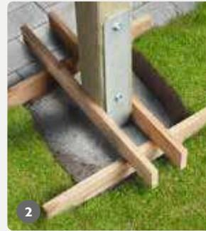
Als Montagehilfe mindestens 2 Latten am Pfostenende fest verschrauben. Lege nun zwei Unterleghölzer unter, damit Du Deinen gewünschten Abstand zwischen Erdboden und Pfosten erhalten. Setze den Pfosten inkl. Träger in das zuvor ausgehobene Fundamentloch (wir empfehlen eine Größe von 35 x 35 cm und 80 cm Tiefe).
