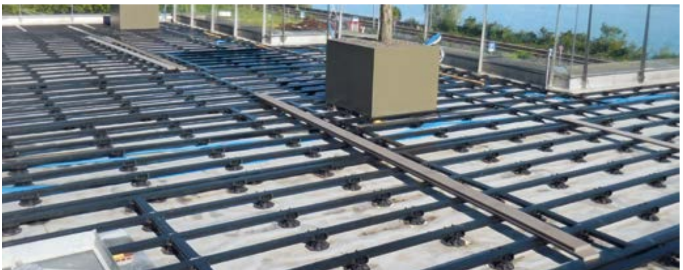
Aluminiumunterkonstruktion mit Stelzlagern und Verstellfüßen.
