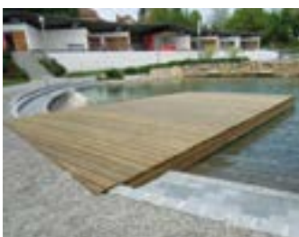
Stege über Wasser
