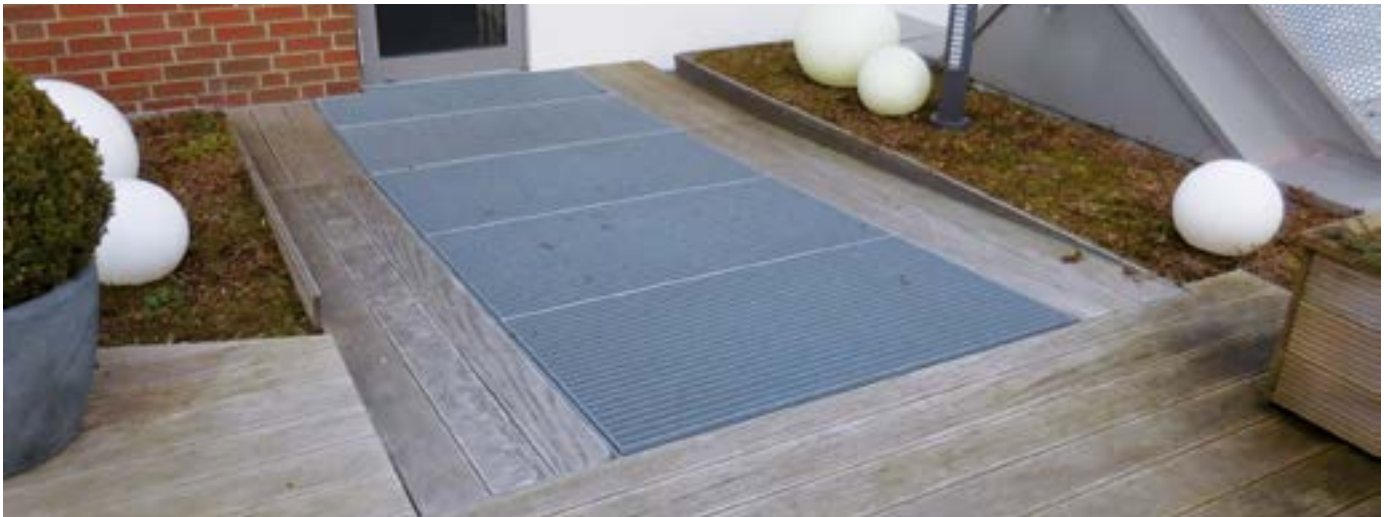
Bei Hoteleingängen sollten eingearbeitete Gitterroste statt Rasenteppiche oder Fußmatten verwendet werden.
