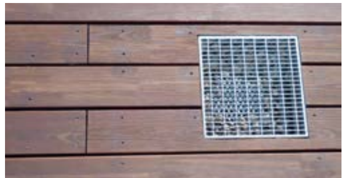
Für Wartungsarbeiten muss die Entwässerung immer zugänglich sein. Mit Entwässerungsrosten ist das einfach möglich.
