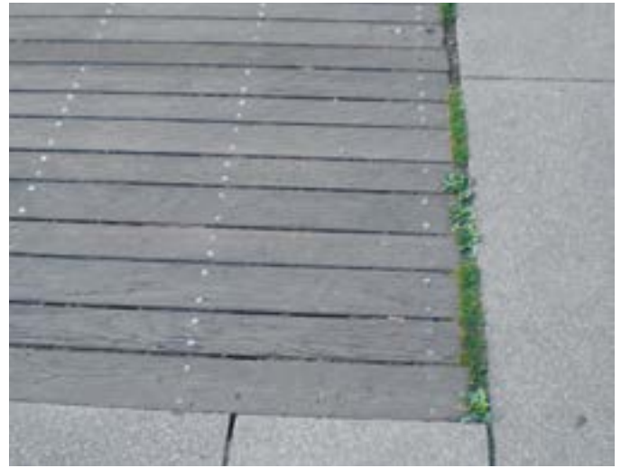
Fugen sollten von Laub, Dreck und Unkraut befreit und dauerhaft sauber gehalten werden.
