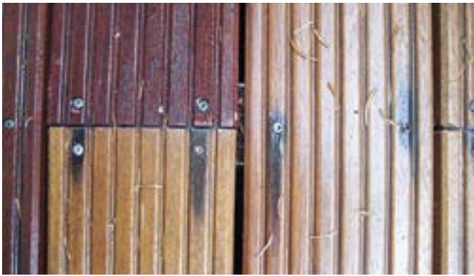
Gerbsäure von Bangkirai hat mit den Schrauben reagiert. Die Verfärbung ist kaum noch zu beseitigen.
