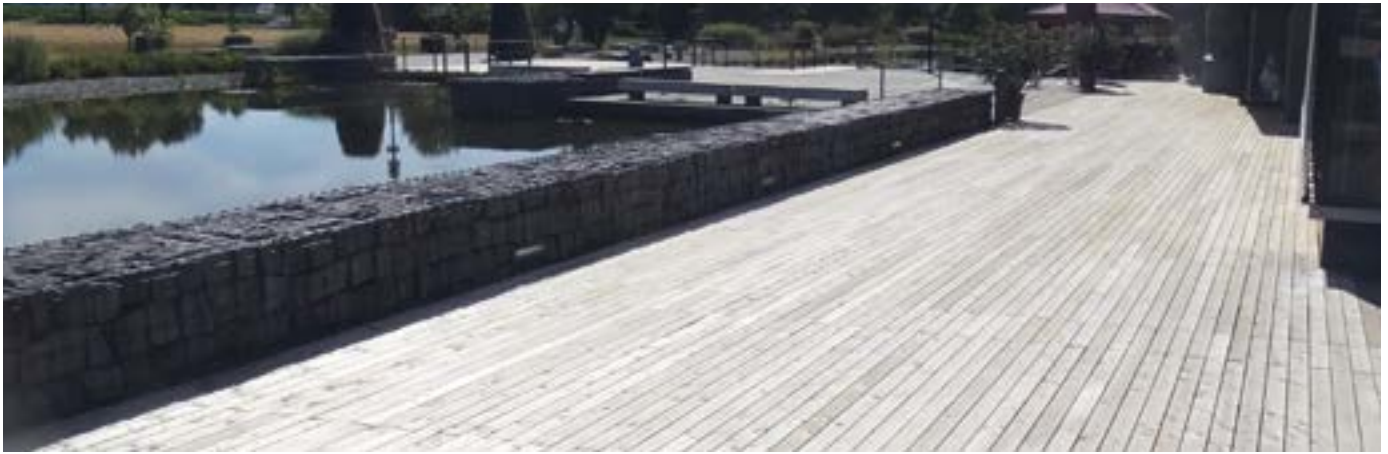
Umwelteinflüsse führen bei Holzterrassen zu einer Vergrauung.
